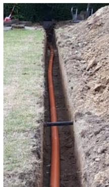
*Rohrgraben für das Erdkabel*
